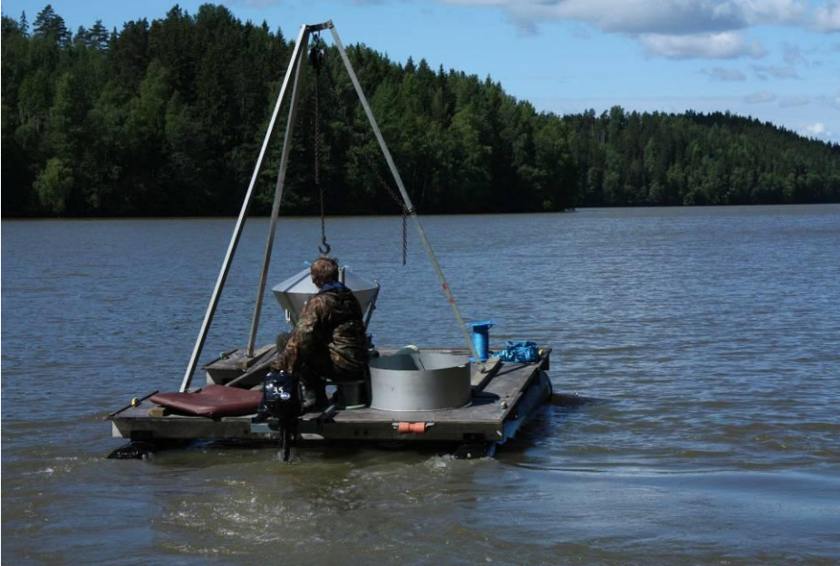
Kuva 2. Kaukjärven hapetuslaitteen asennus
